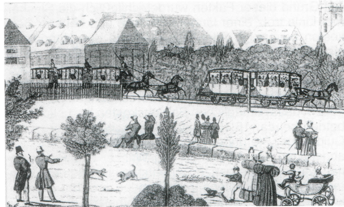
Abb. 5: Auf der Ludwigs-Eisenbahn Nürnberg-Fürth wurde wegen der für die Lokomotive benötigten teuren Steinkohlen der Hauptbetrieb mit Pferden abgewickelt. Dabei wurden zwei Wagen von einem Pferd, mehrere Wagen von zwei Pferden gezogen. (Litho bei C. Trummer, Nürnberg).
