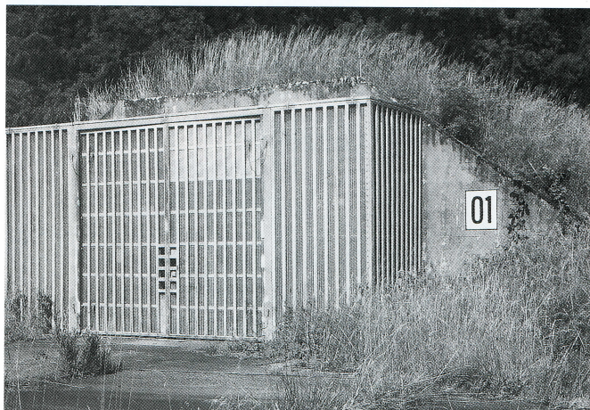
Abb. 46: Amerikanischer Tresorbunker für die Atomsprenköpfe der Pershing-Raketen.
