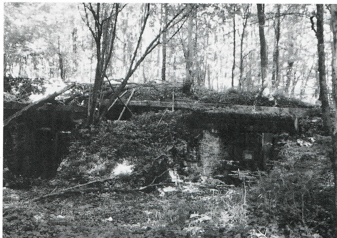
Abb. 44: Zerstörtes Munitionshaus der HMA
